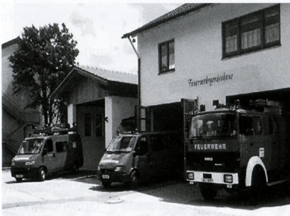
Die Garagen nach dem Neubau und der Renovierung Foto: Feuerwehr
